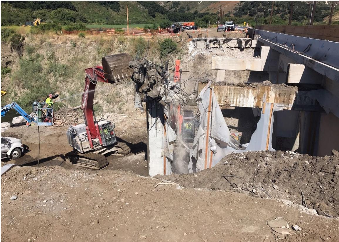
Figure 6-20. Bent Cap Removal, Salsipuedes Creek
